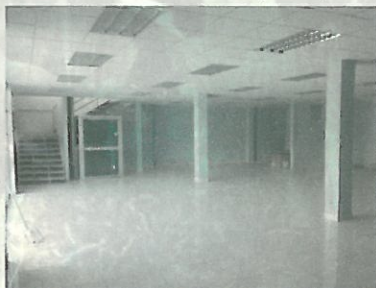
Fig. 6 – Foto mirando a las escaleras y ascensor
